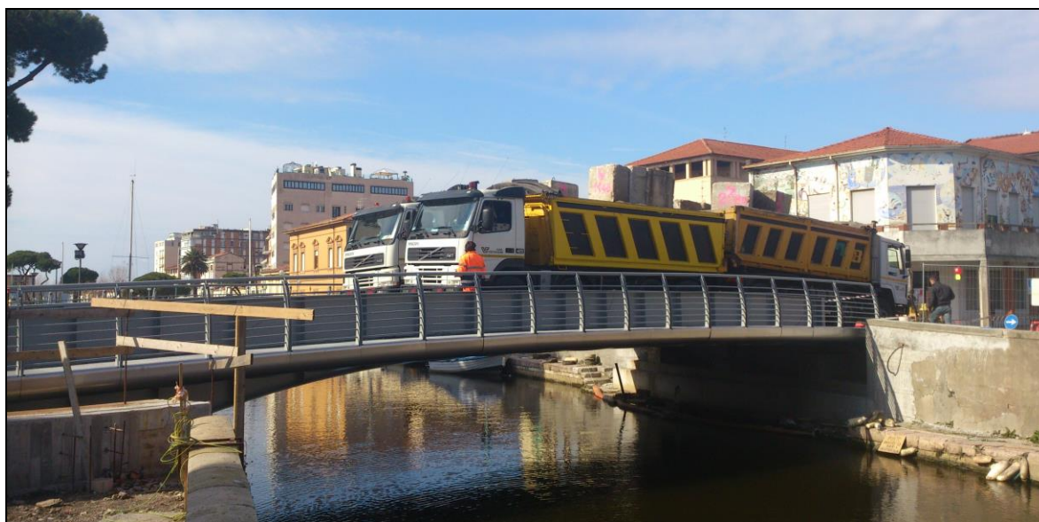
Fig. 28: prove di carico sul nuovo ponte girante sul Canale Burlamacca a Viareggio
