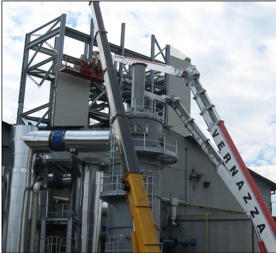
Fig. 5: struttura metallica per il nuovo forno "Asarco" - K.M.E. Italy - Fornaci di Barga (LU)
