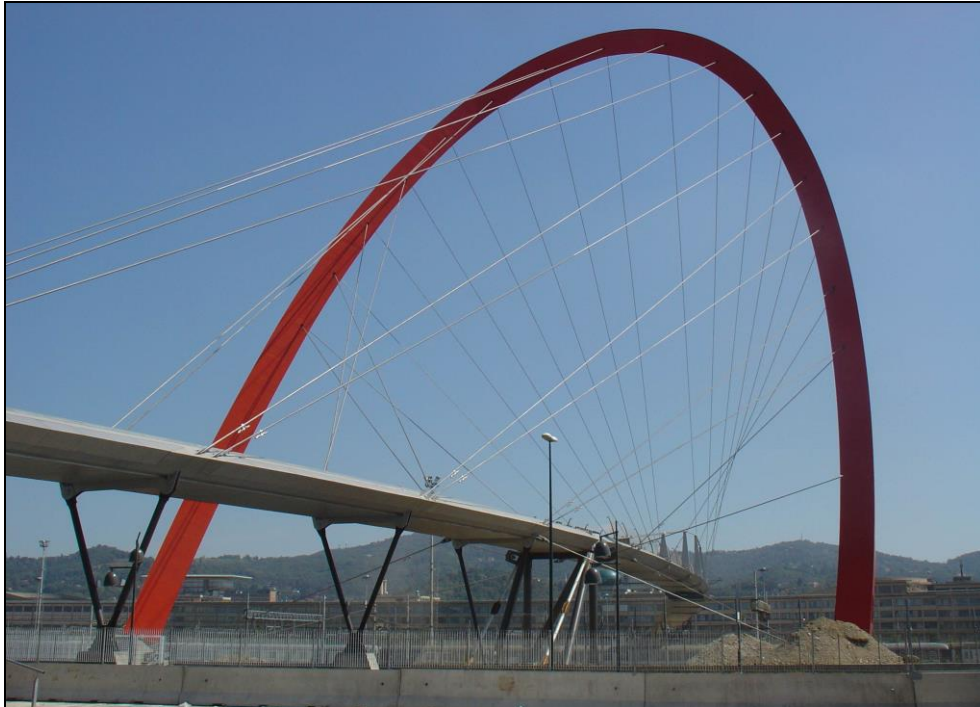
Fig. 26: la Passerella Olimpica di collegamento tra il Nuovo Villaggio Olimpico e il Lingotto - Torino 2006
