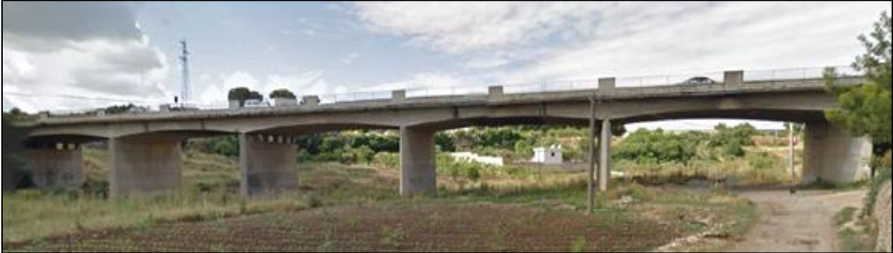
Fig. 20: viadotto sulla Lama Balice presso Bitonto (BA)
