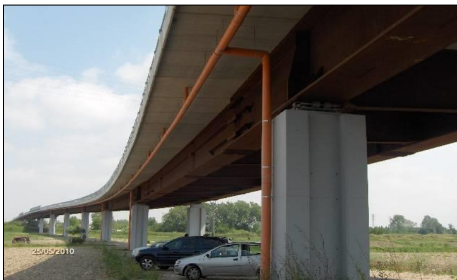
Fig. 33: il Viadotto "Reghena" sulla SS. 14 – Variante di Portogruaro
