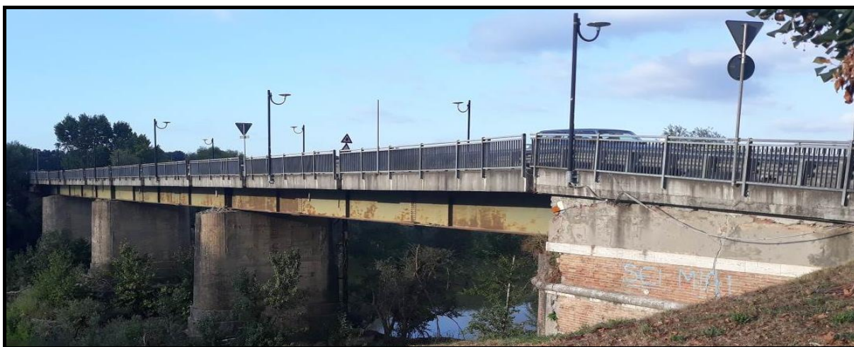
Fig. 22: ponte sul fiume Arno, al km 0+780 della SP 6 "di Giuncheto"
