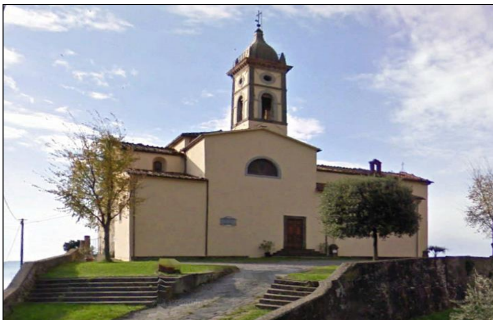
Fig. 34: Complesso Parrocchiale di Tofori (LU)
